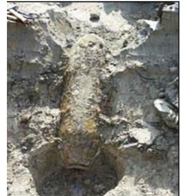
Abb. 1 Fliegerbombe, angetroffen bei Bauarbeiten in der Nähe einer Tankstelle
