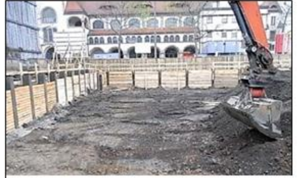
Abb. 4 Schichtenweiser Abtrag, verpflichtend bei baubegleitender KMR
