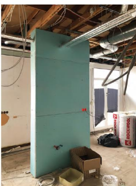
HLS, Elektro, Trockenbau Küche
