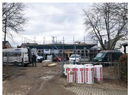
Zufahrt Baustelle Auwanne
