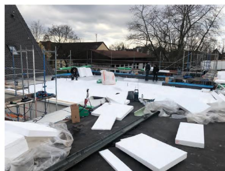
Dacharbeiten / Verlegung Gefälledämmung
