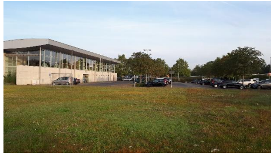
Blick von Süden Richtung Lindighalle
