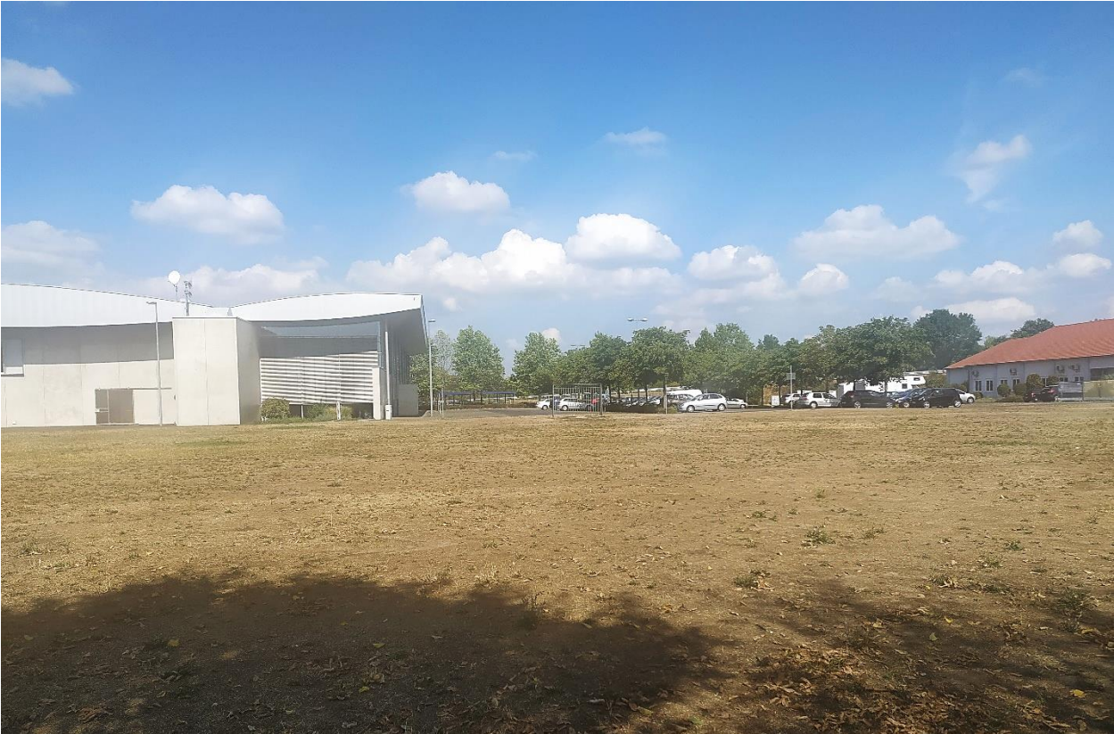
Abb.3: Blick von Süden auf die Lindighalle
