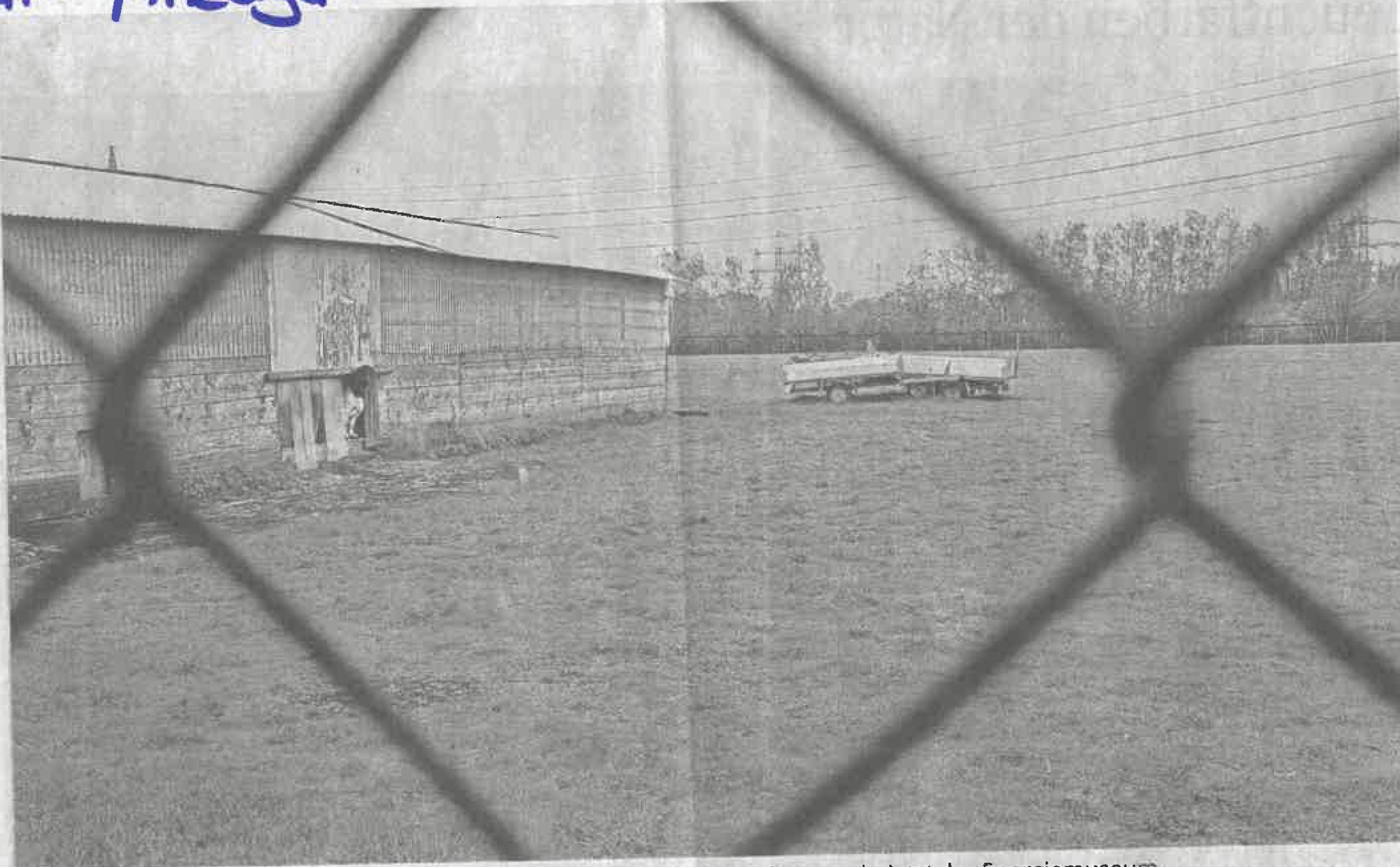
Das Kernkraftwerk Kahl wurde komplett zurückgebaut. Auf dem Gelände entsteht jetzt das Energiemuseum.
