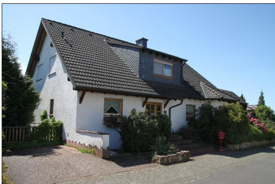
Abb. 7: Bestandsgebäude Flst. 2333/47 (eigene Aufnahme)
