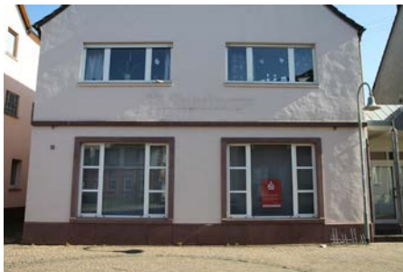
Abb. 3-4: Gebäude mit leichtem Sanierungsbedarf
