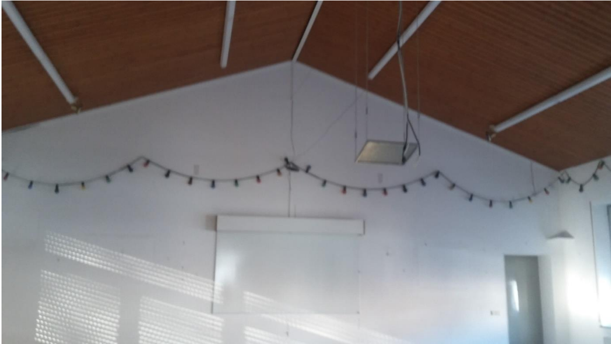
Abb.2: Foto aus dem Innenbereich der Gebäudestruktur.
