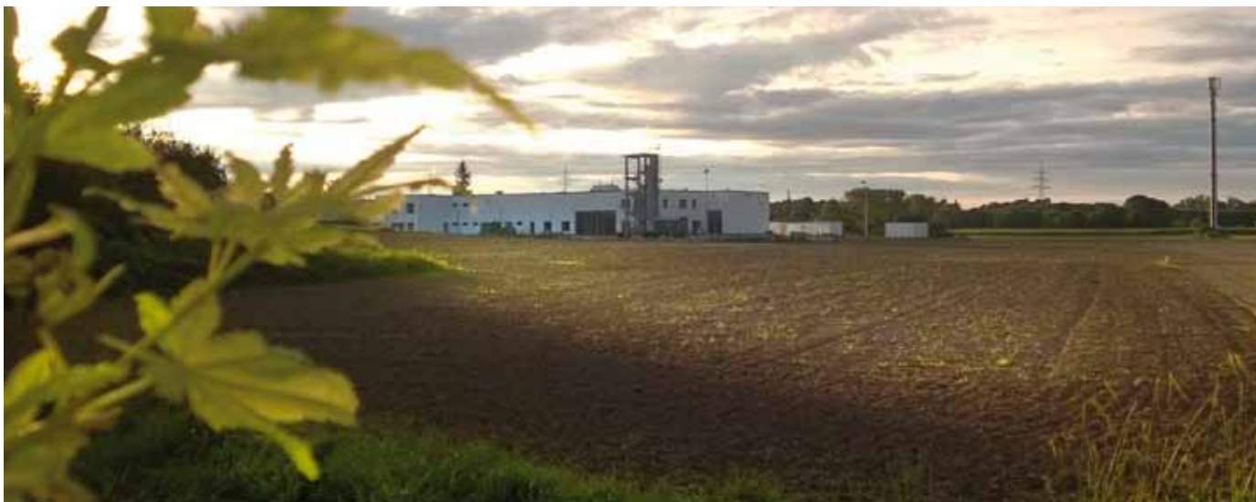
Das neue Feuerwehrhaus Karlstein während der Bauphase im Sommer 2017 in der Feldflur
