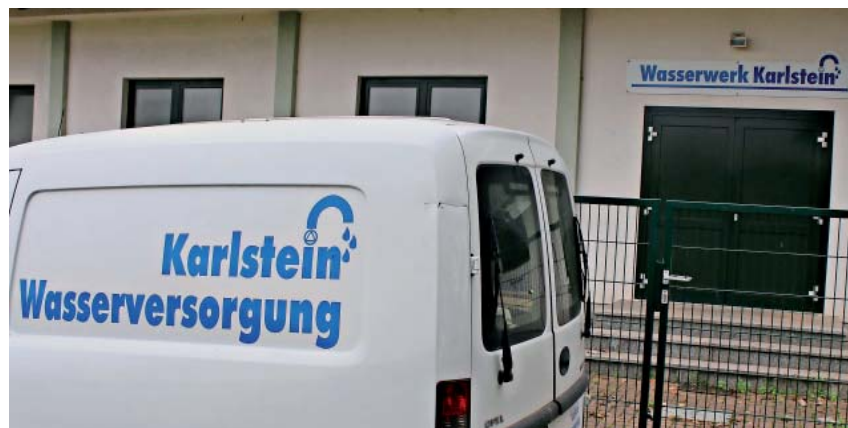
Wasserwerk in Dettingen
