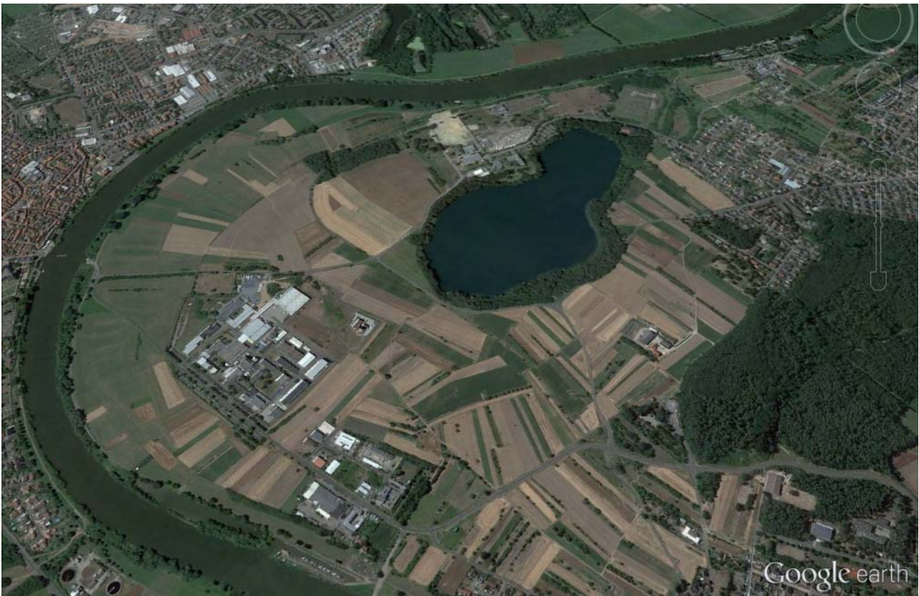
Gewerbegebiet im westlichen Gemeindegebiet
