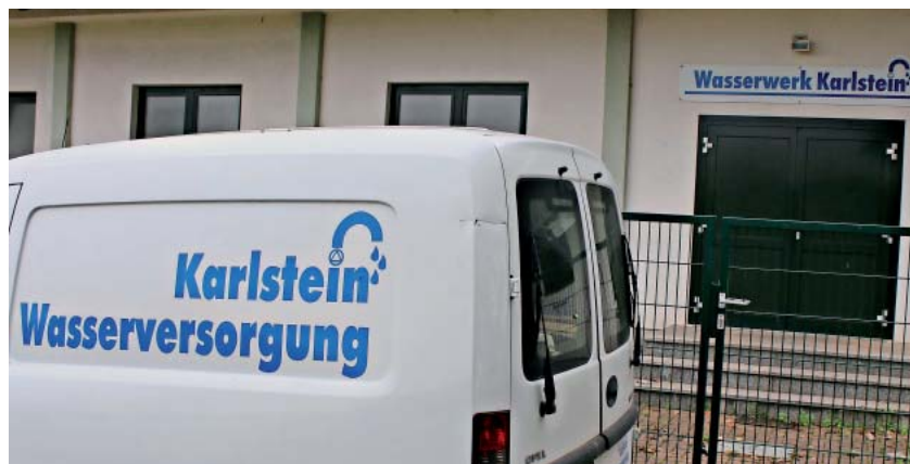
Wasserwerk in Dettingen
